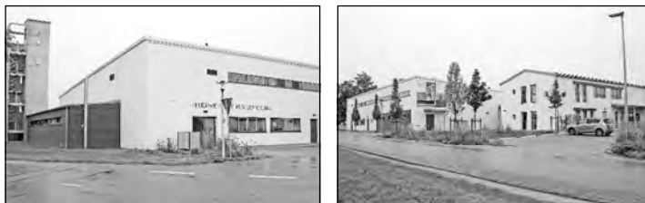
Neues Schierlinger Feuerwehrzentrum
