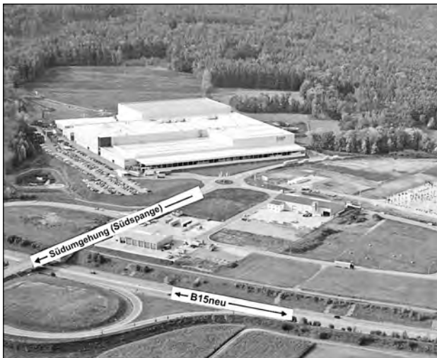
Das neue Gewerbegebiet „Am Birlbaum“ im Südwesten von Schierling
