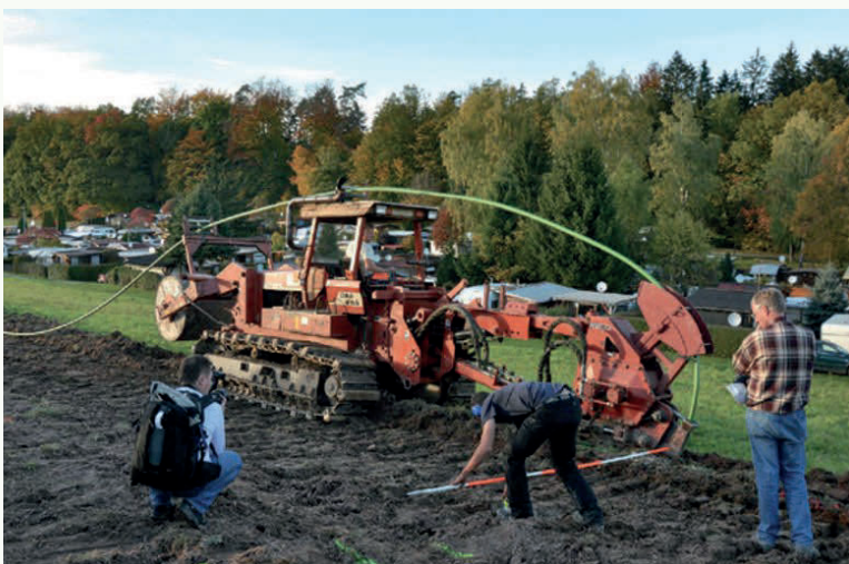
Mit einem solchen Gerät kann der Agrothermie-Kollektor in den Boden eingebracht werden. (Quelle: Bauma).
