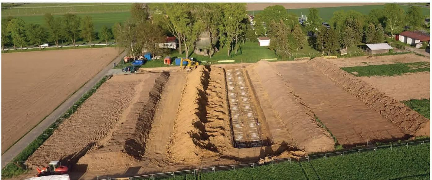
In Bad Nauheim wurde der Kollektor in offener Bauweise im Boden verlegt. In Schierling ist das Einpflügen des „Agrothermie-Kollektors“ möglich und kostengünstiger.
