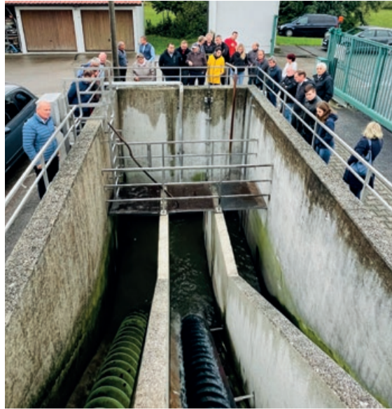
Die neue Schnecke im Hebewerk wurde ganz genau begutachtet.
