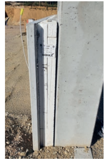
Auch in den als Sockel dienenden Betonteilen ist die Isolierung bereits integriert.
