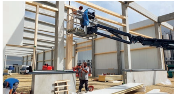
Wesentliche nichttragende Teile des neuen Gebäudes sind in Massivholz ausgeführt. Eine Bauweise ganz in Holz kam aus Brandschutzgründen nicht in Frage.
