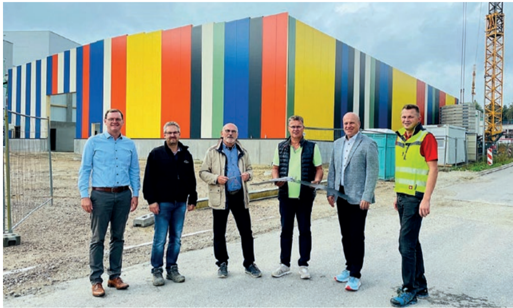
Das Kommunalunternehmen Markt Schierling baut im Gewerbegebiet „Am Birbaum“ eine gewerbliche Halle nach höchsten energetischen Standards. Auf der Baustelle besprachen Einzelheiten – von links – Vorstand und Geschäftsleiter Manuel Kammermeier, Bauleiter Martin Mittermaier von der Firma Laumer, Vorstand Fritz Wallner, Architekt Norbert Hecht, Bürgermeister Christian Kiendl und Andreas Zellner von der Firma SMP.
