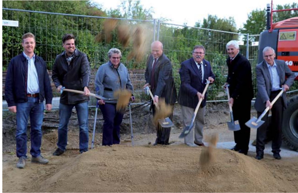
Den Spatenstich für die Erweiterung der P+R-Anlage am Bahnhof Eggmühl machten, von links, Thomas Schweiger-Beck von Fahrner Bau, Ingenieur Martin Dietl, zweite Bürgermeisterin Maria Feigl, Bürgermeister Christian Kiendl, stellvertretender Landrat Willi Hogger, dritter Bürgermeister Anton Blabl und Wolfgang Treppesch von der Eisenbahninitiative
