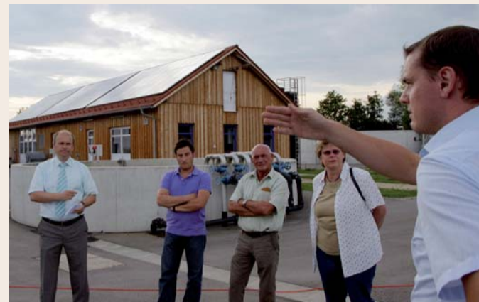
Vorstand Manuel Kammermeier vom Kommunalunternehmen erläutert die Photovoltaikanlage auf dem Dach eines Kläranlagengebäudes
