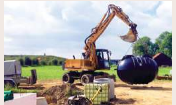
Der Markt Schierling fördert den nachträglichen Einbau von Regenwasserzisternen, die heute insbesondere für die Nachrüstung vorgefertigt geliefert und in die Baugrube eingehoben werden
