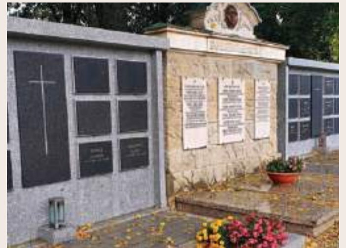
Die Urnenwände fügen sich sehr gut in das Gesamtbild des Friedhofs ein
