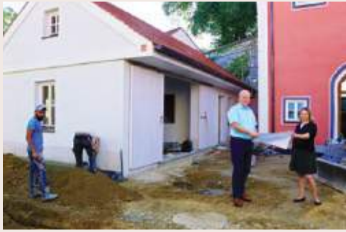
Bürgermeister Christian Kiendl und Bauamtsleiterin Nina Kellner besichtigten die Baustelle am alten Schulhaus Schierling, wo ein kleiner sympathischer Platz für die Feier von standesamtlichen Trauungen entstanden ist
