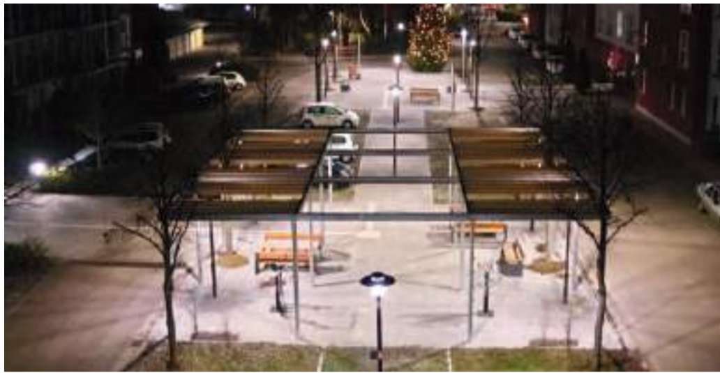
Im Schierlinger „neuen Ortskern“ beim Seniorenheim entstand ein neuer Platz mit hoher Aufenthaltsqualität, der kurz vor dem Winter fertiggestellt wurde
