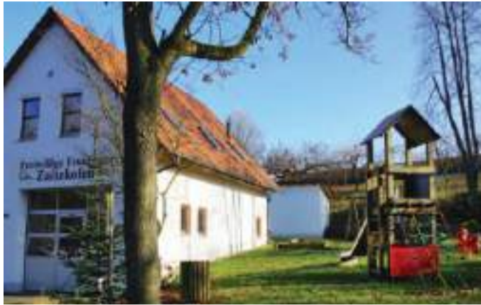
Die Feuerwehr Zaitzkofen hat in Eigenleistung einen Geräteschuppen erstellt
