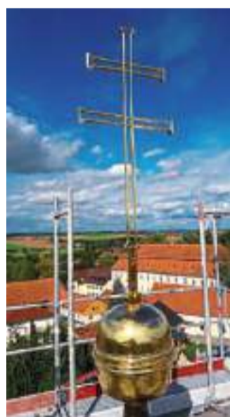
Das restaurierte Turmkreuz in Zaitzkofen ist weit sichtbar
