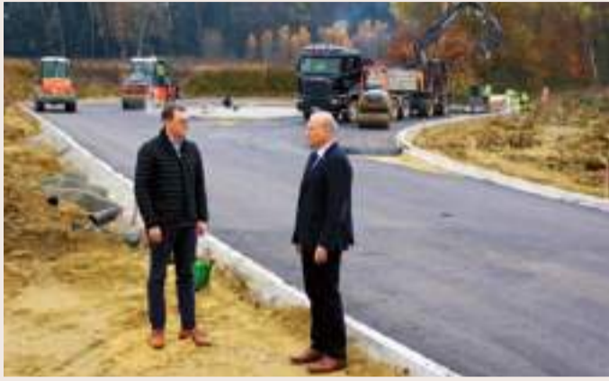
Im Schierlinger Gewerbegebiet „Am Birlbaum“ wurden weitere Erschließungsanlagen gebaut
