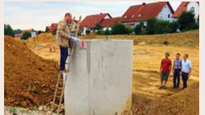
In neuen Wohnbaugebieten wurden Regenwasserspeicher aus Beton gesetzt
