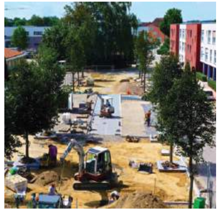
Die umfangreichen Arbeiten stießen auch bei der Bevölkerung auf beachtliches Interesse
