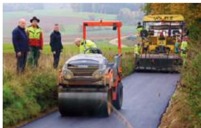
Bürgermeister Christian Kiendl, Allersdorfs Jagdvorsteher Andreas Piendl-Rötzer und Hermann Diermeier vom Bauamt überzeugten sich von den Asphaltierungsarbeiten
