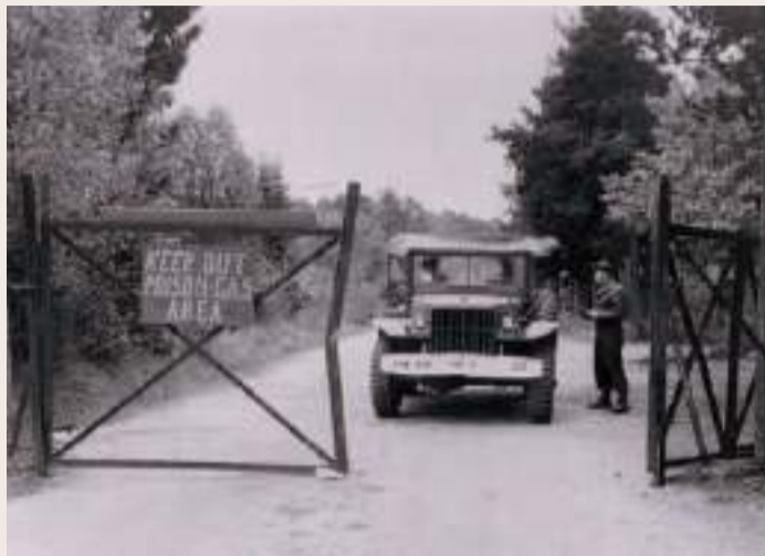
Nach der Übernahme der „Luftmunitionsanstalt Schierling“ durch die Amerikaner am 29. April 1945 machten diese schon am Eingang deutlich, dass man sich von diesem Giftgasbereich fernhalten muss
