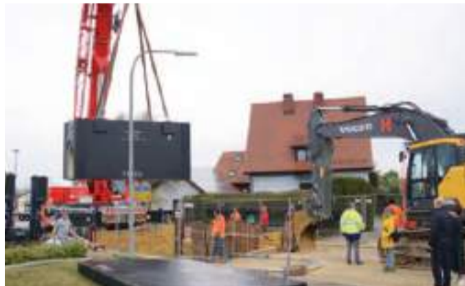
An der Kreuzung Waldstraße-/Eggmühler Straße wurde ein tonnenschweres Kreuzungsbauwerk eingehoben
