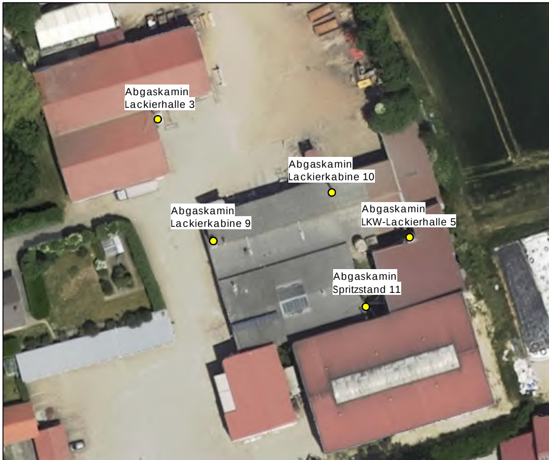
Abbildung 6: Übersicht der Abgaskamine des Sandstrahl- und Lackierbetriebs /18/
